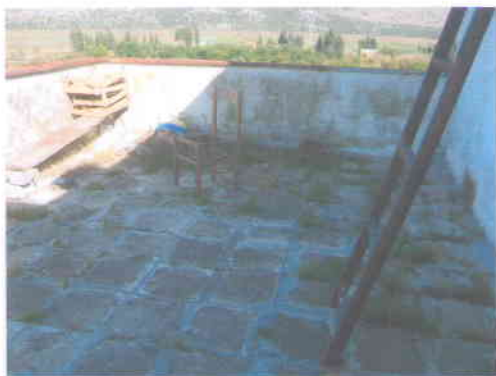
2. prohodna terasa sa betonskim opločnicima
